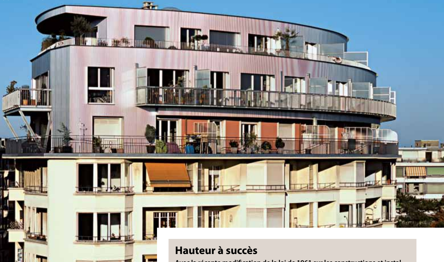
Surélever un bâtiment de l'architecte Braillard est un exercice de style.
